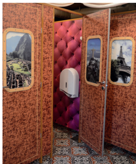
LTT 24 mm tryklaminat, lakeret aluminiumsprofil, Borgbacken bandal
